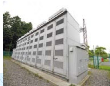
6年前に導入されたNAS電池。工場の約3分の1の電力をまかなうことができるそうです
